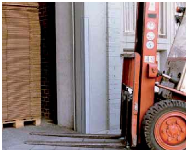
Пример: Уголок для защиты краев на краях стен и колонн в производственном помещении
