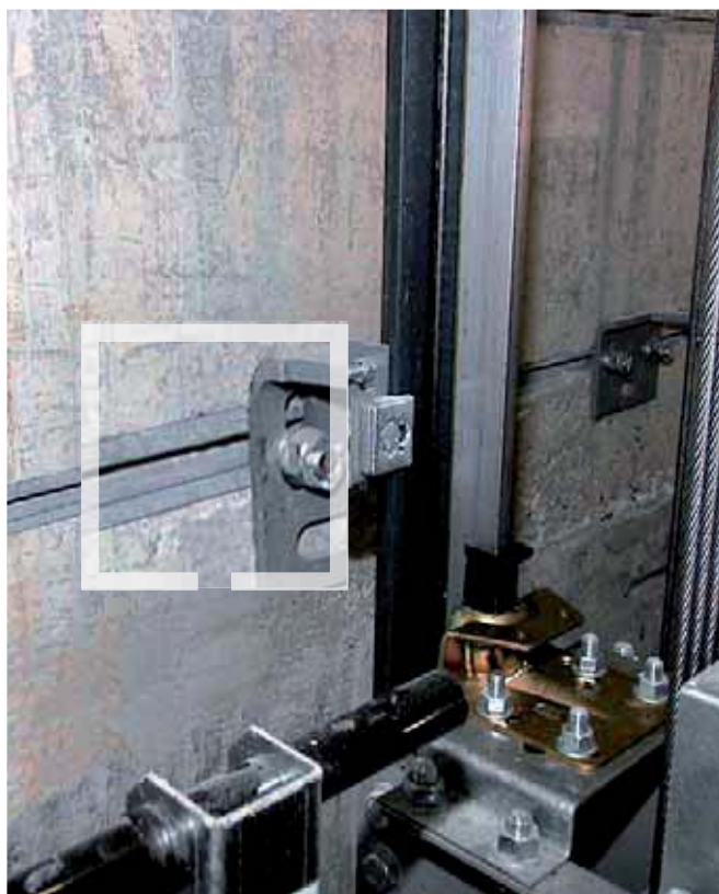
Строительство лифтов: Крепление направляющих
