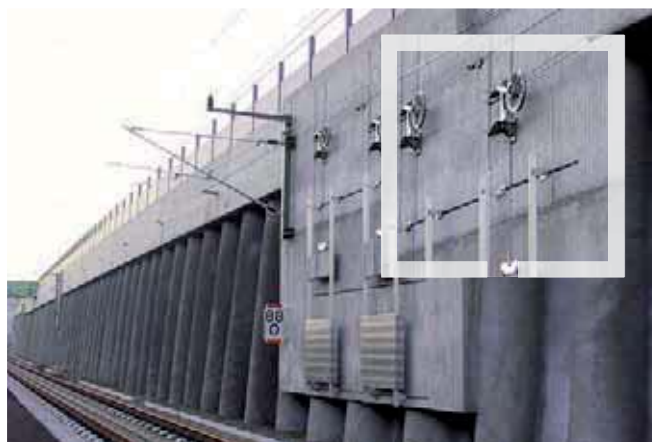
Тоннельное строительство: Крепление натяжных устройств контактной сети
