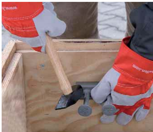
Шины Halfen прибить к опалубке гвоздями
