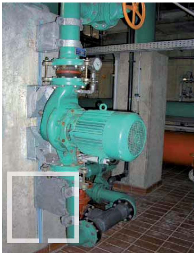
Крепление водопровода
