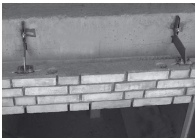
Закладные элементы HK4-SV и HTA-ES для перемычек заводского изготовления
